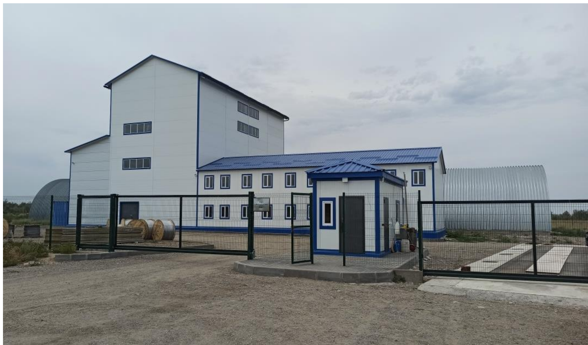
Соевый завод Строительство бескаркасного ангара для соевого завода
