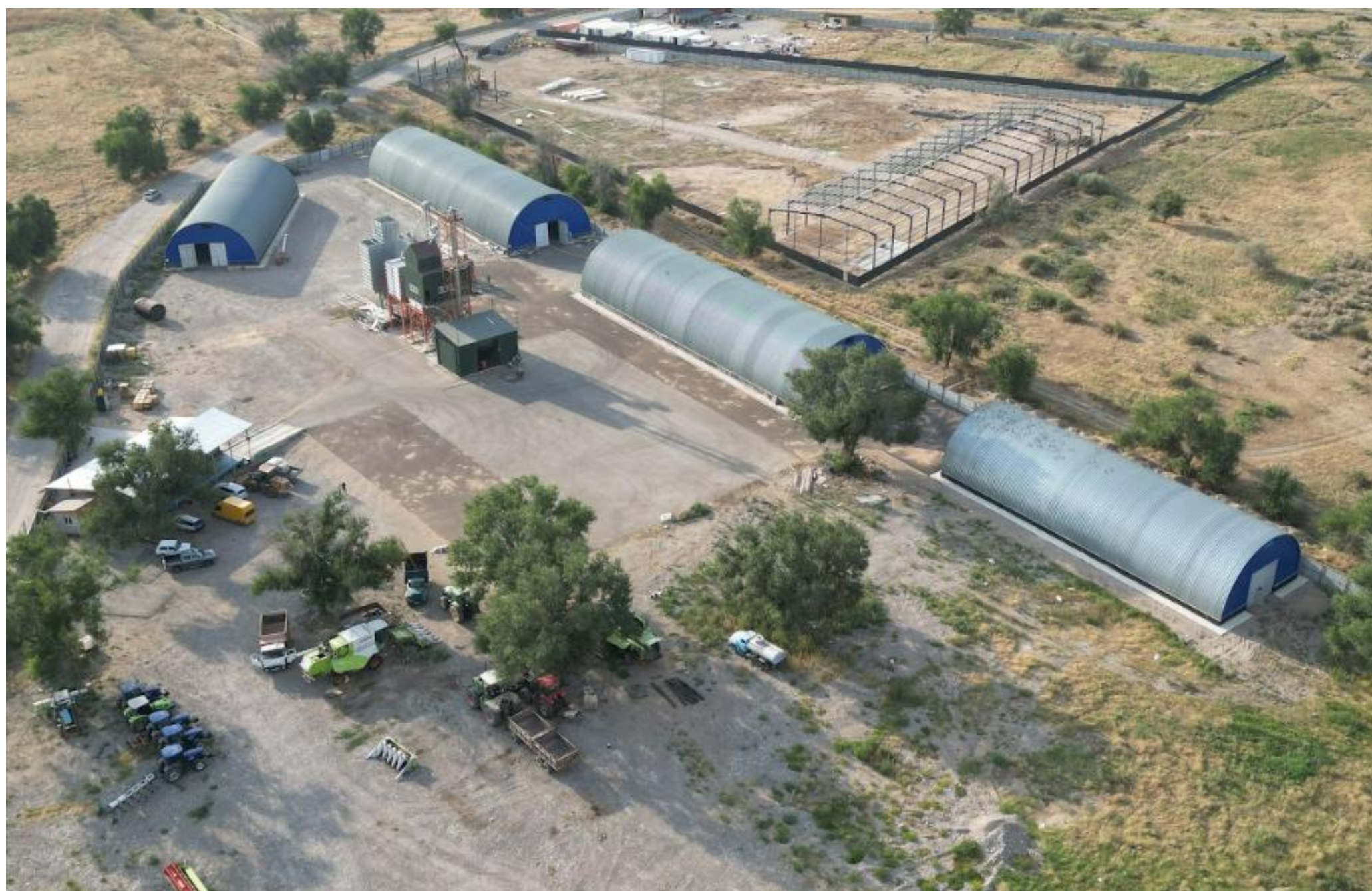
Алматиская область Комплекс ангаров под зернохранилище
